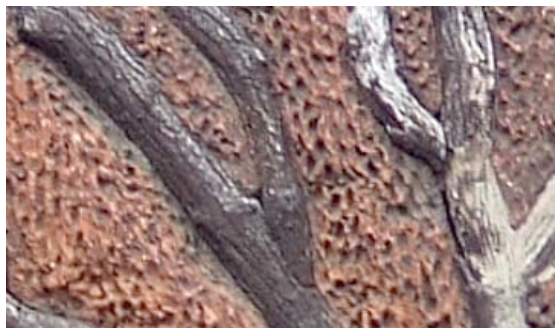
La maison Woodcottage : vue de détail sur les pans de mur
