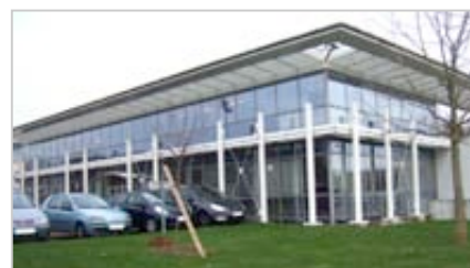
Des bâtis récents qui présentent un bon niveau d'esthétisme
