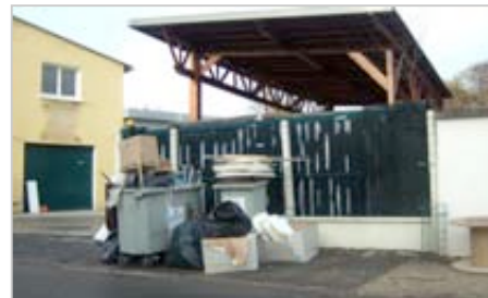
Problème de stockage des déchets sur la ZA du Prunay
