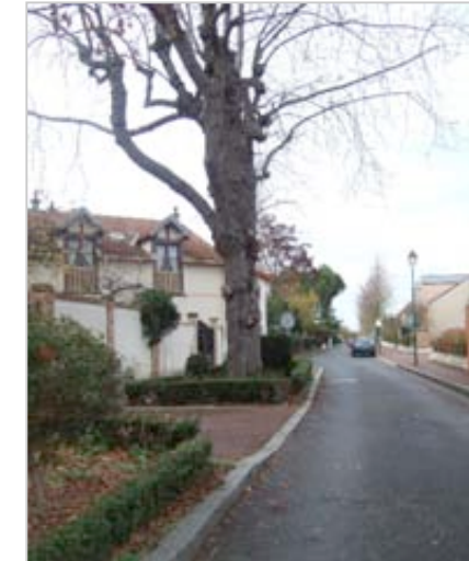
Aménagement de trottoir et mise en valeur d'un arbre (Croissy-s/Seine)
