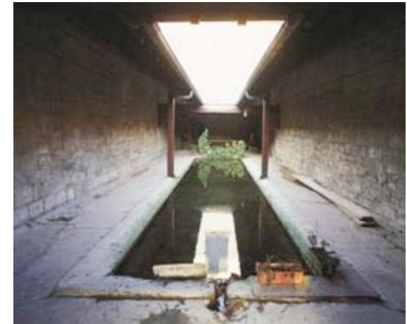
Le lavoir à Carrières-sur-Seine
